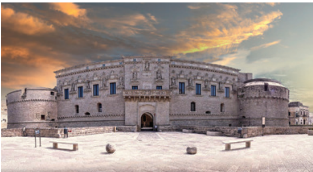
La splendida facciata del Castello de Monti di Corigliano d'Otranto. Il castello, a pianta quadrangolare, fu totalmente ristrutturato dalla famiglia De Monti, feudatari dell'area nel Quattrocento, probabilmente su una precedente struttura di età medievale. Fu dotato di possenti mura bastionate e di quattro torrioni cilindrici ai lati, ciascuno dedicato ad un Santo.
